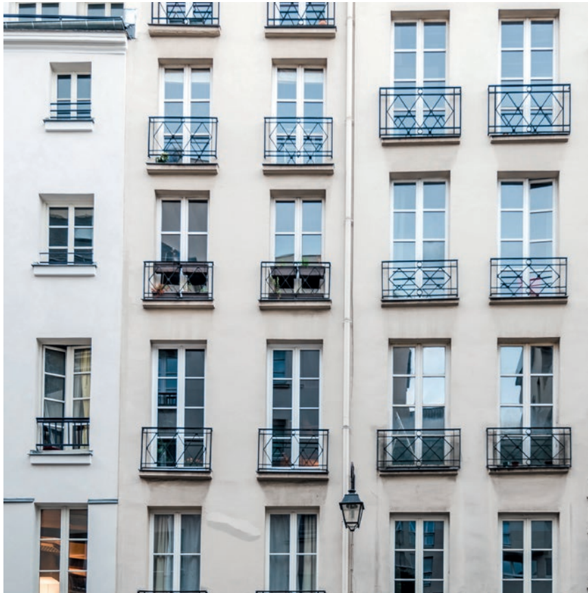
Abb. 20: Klassische Pariser Fassaden mit kleinen Balkonen im nicht restaurierten Zustand
