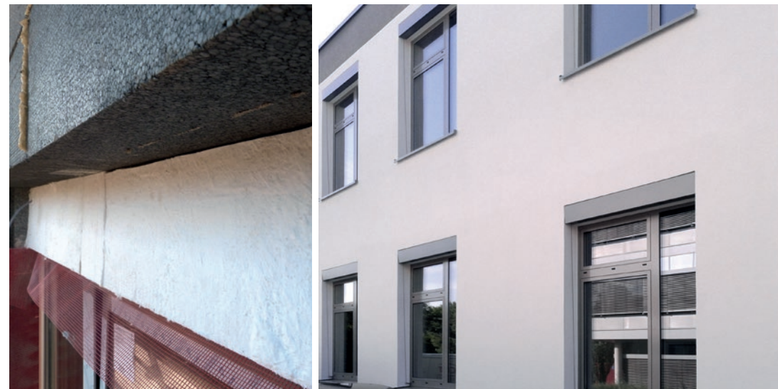
Abb. 18: Beispielhafte Ausführung einer Wärmedämmung mit SLENTEX® hinter einem Rollladenkasten (hier in Kombination mit EPS) 1) Gebäudewand, 2) Klebemörtel, 3) konventioneller Dämmstoff, 4–6) Mörtel mit Armierung, 7) Decklage mit Putz und Farbe, 8) SLENTEX® , 9) Raffstore- oder Rollladenkasten, 10) Fensterglas
