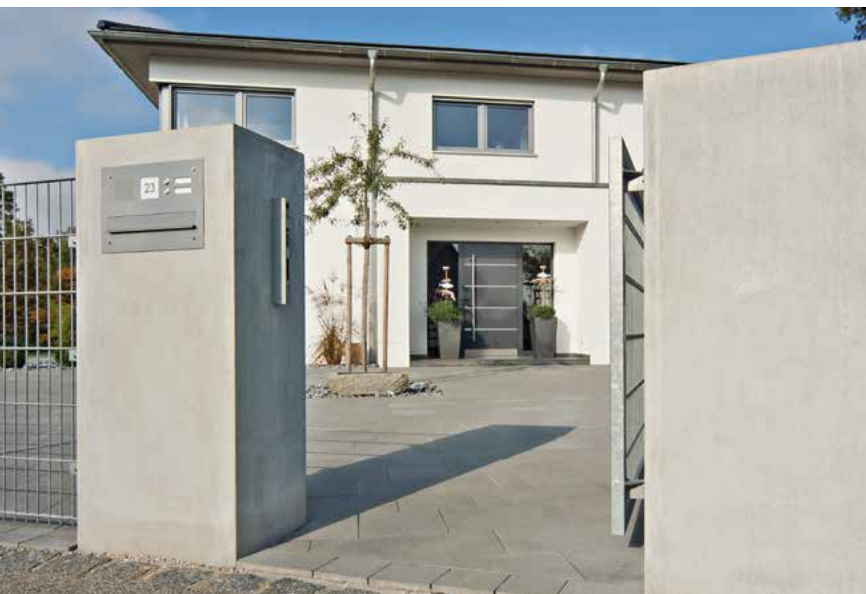
Posten Sichtbeton Grau mit integriertem Briefkasten und MOLINA samtiert Grau dunkel Großpflastersystem
