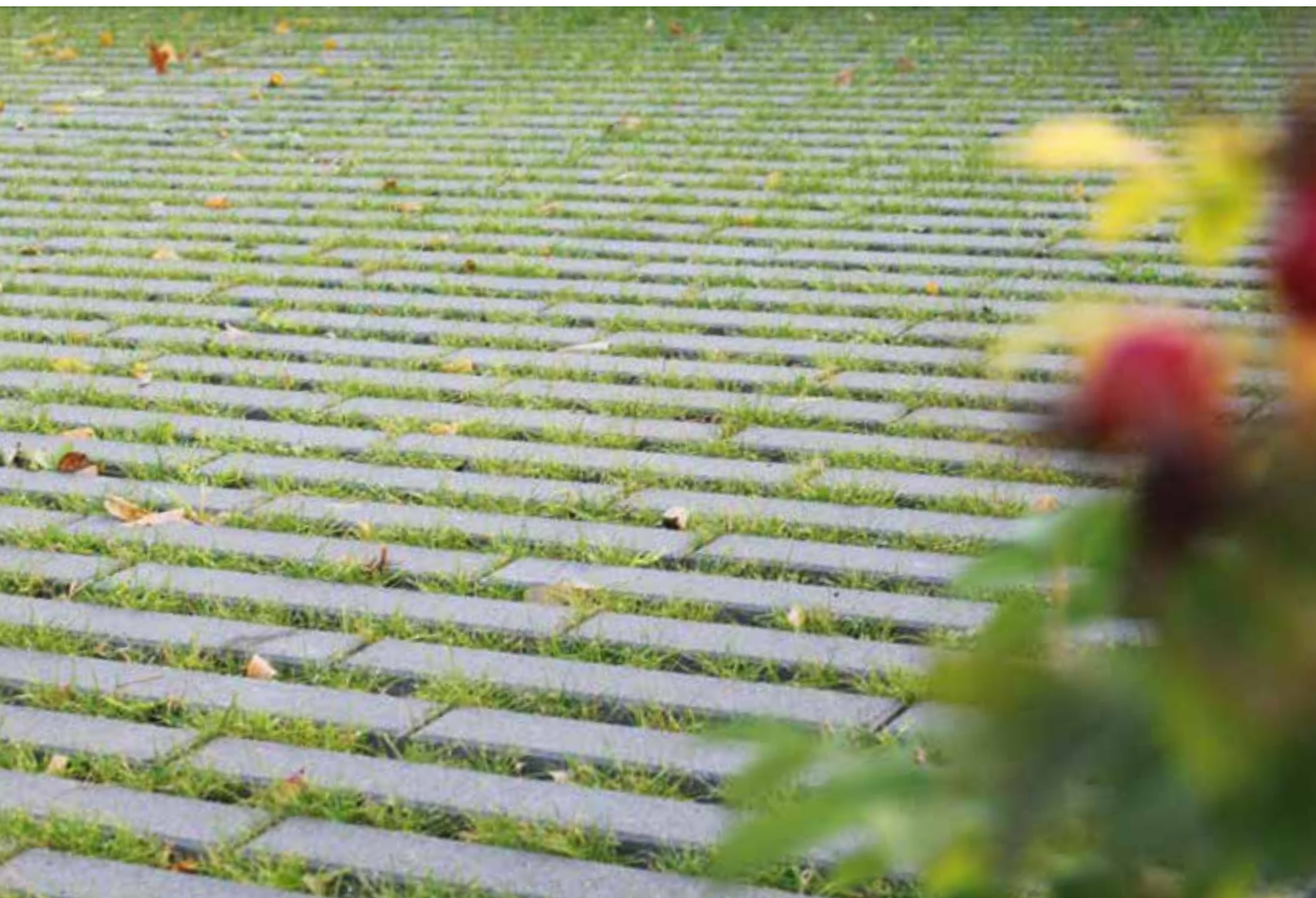
SCADA Rasenliner nativo VZ4 Grau 40/10/12 cm
